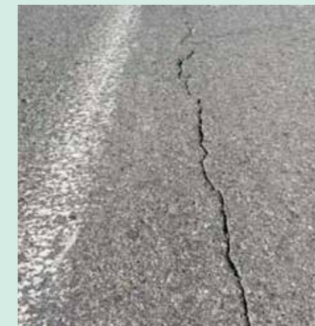
Technologinis plyšys skirtingų eismo juostų dangos sujungimo vietoje
